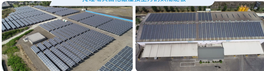
掩埋場與固化廠屋頂上方的太陽能板
