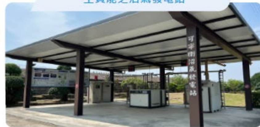
生質能之沼氣發電站
